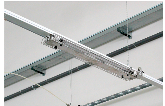
Einsatz im industriellen Umfeld
